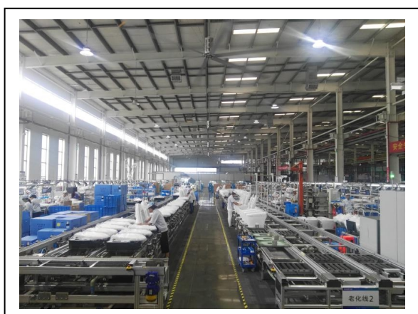
图 3 车间冷水机空调
